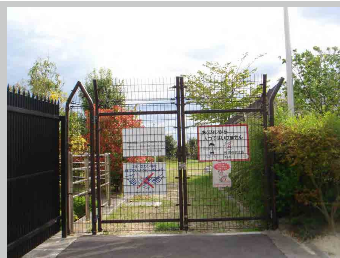
千里山神社横の千里山配水場入口
