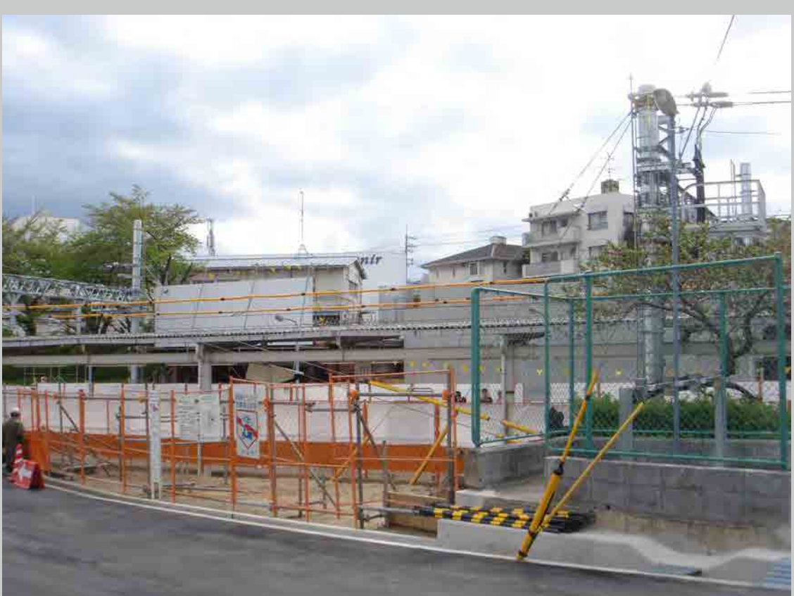
駅東側（工事中）
