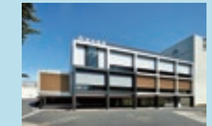
防災機能を備える施設「東体育館」
