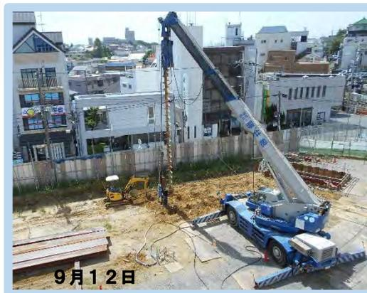
駅前ロータリー予定地では、引き続き公共下水道(雨水を排除する施設)の整備が行われています。地面を掘って、新たな下水道管を埋設する準備として土留めを設置しています。
